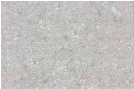
卫生间地面和墙面
